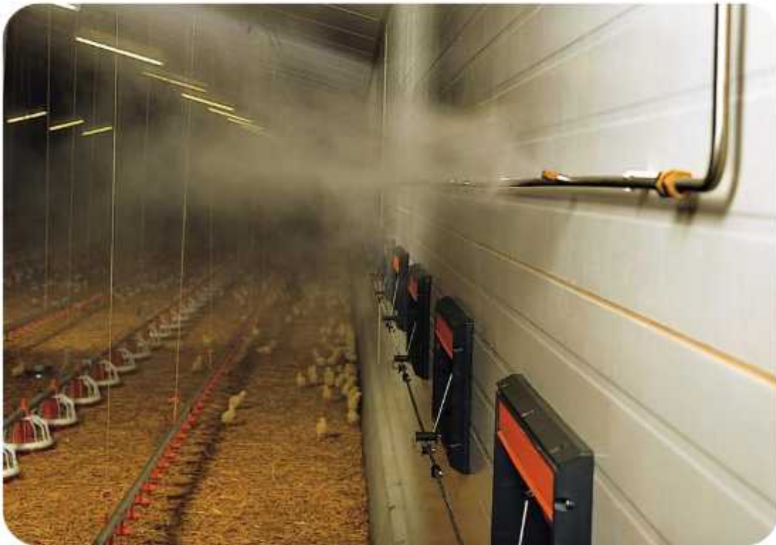
شکل ۱۱- سیستم خنک‌کننده مه‌پاش در داخل آشیانه به منظور تأمین رطوبت
